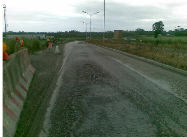
La struttura portante del ponte presenta una delle due travi esterne danneggiata a causa di un urto incidentale che ha reso necessario per ragioni di sicurezza procedere ad un restringimento della carreggiata.
