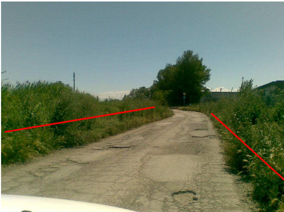
La strada attualmente ha una larghezza di 4 m. Dovrà essere portata fino a 8 m bonificando le zone laterali e realizzando un nuovo pacchetto stradale. Viste le condizioni di degrado andrà ristrutturata anche la parte esistente considerando il traffico che dovrà sopportare durante i lavori.
