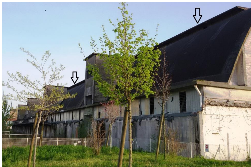
Fotografia 1: Catterin (2015), con le frecce nere viene indicato dove è previsto il posizionamento dei pannelli fotovoltaici.
