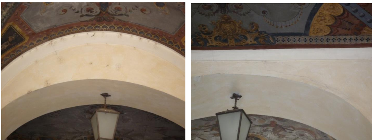
Fessurazioni sugli archi in laterizio del piano terra del Palazzo Merlato
