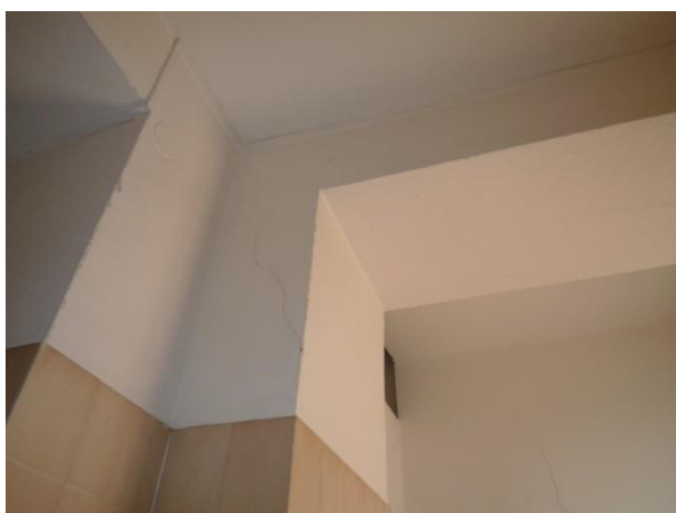
Stati fessurativi visibili sulle murature interne degli edifici
