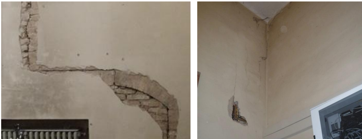
Discontinuità nelle murature degli edifici
