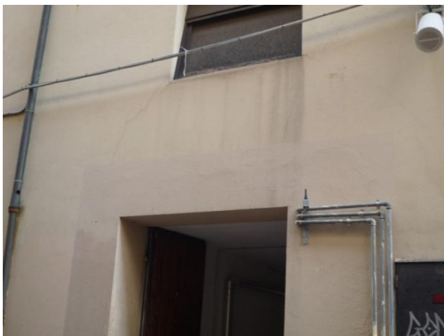
Stati fessurativi visibili sulle murature dei prospetti degli edifici
