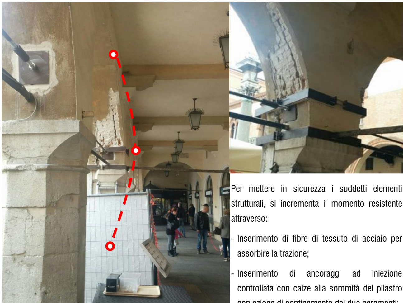
Figura 2-3: Lesione su un pilastro del portico di Palazzo Merlato
