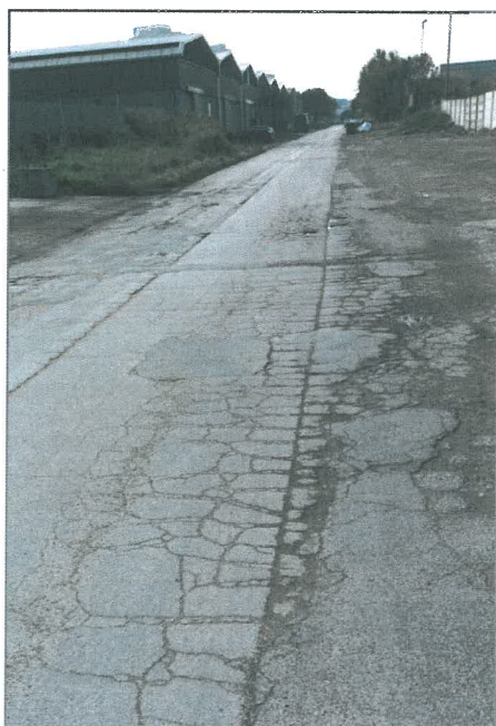
Figura 2. Ammaloramento superficiale della pavimentazione
