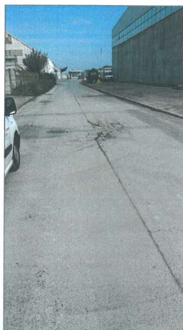
Figura 2. Ammaloramento superficiale della pavimentazione
