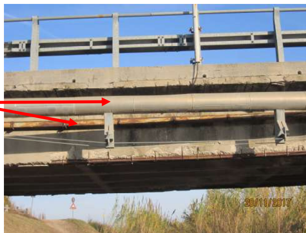
SOTTOSERVIZI HERA IN APPODIATO E CANALETTA TELECOM STAFFATA ALLE TRAVI LATO MONTE
