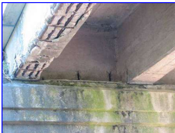
Foto 9: sulle pile, in prossimità degli appoggi si nota il deterioramento del calcestruzzo con conseguente diminuzione della superficie d'appoggio.
