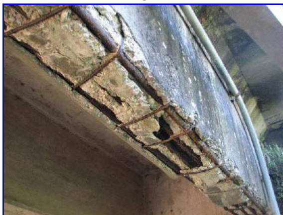
Foto 20: ovunque all'intradosso delle travi esterne le staffe sono corrose con sezione resistente ridotta.
