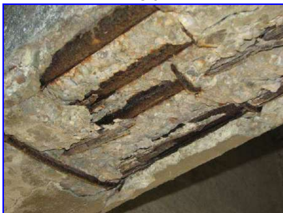
Foto 19: nelle zone delle travi di bordo in cui è avvenuto il distacco del copriferro l'armatura affiorante è corrosa con riduzione di sezione resistente.
