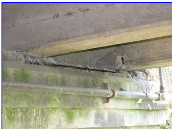
Foto 3: su entrambe le spalle gli appoggi con le travi risultano deteriorati con conseguente diminuzione della superficie d'appoggio.
