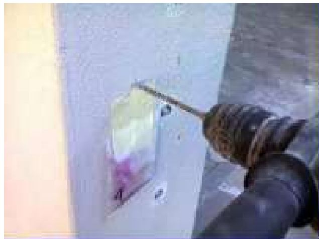
Esecuzione del foro e recupero polveri
