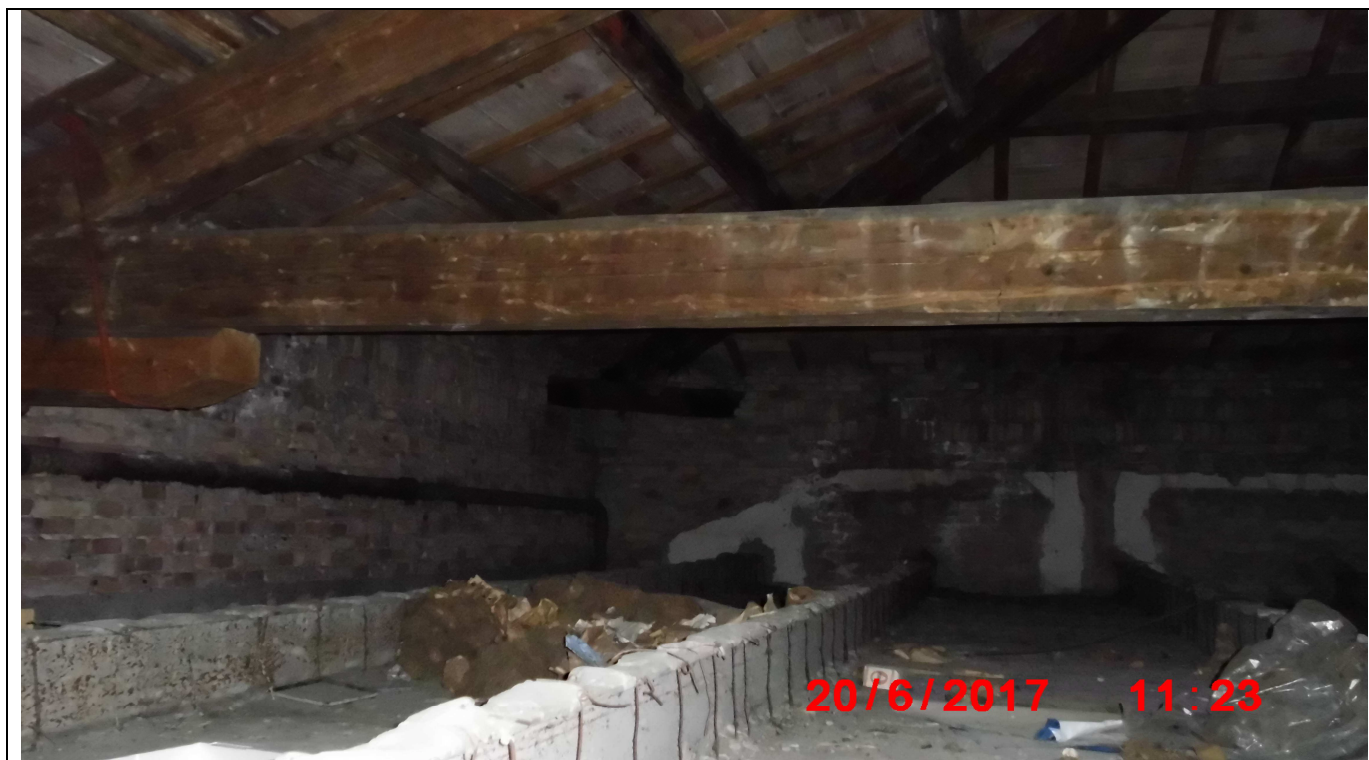
Controsoffitto di tipo "Perret" estradosso
