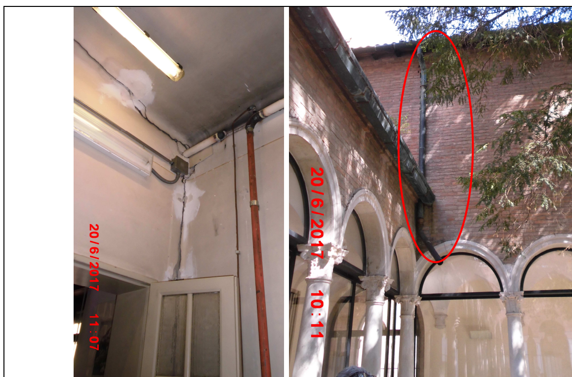
Lesione/giunto naturale tra corpo principale e corpo allungato
