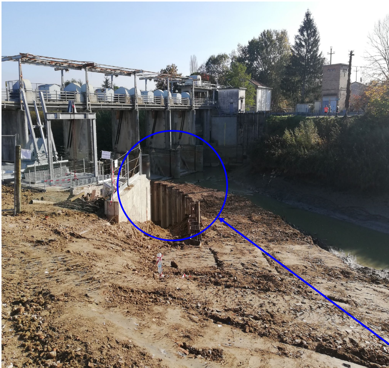
Palancola realizzata dopo il crollo
