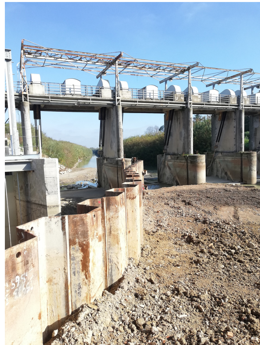
Palancola realizzata dopo il crollo
