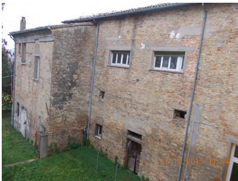
Foto 5 – Lato interno ala ovest
