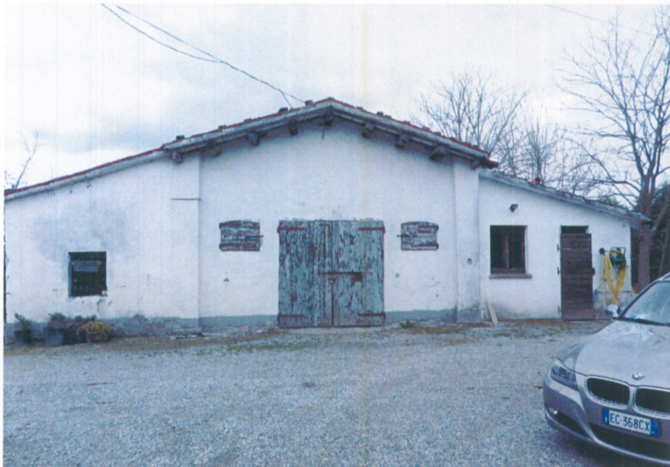
13) Veduta prospetto nord servizio (2)
