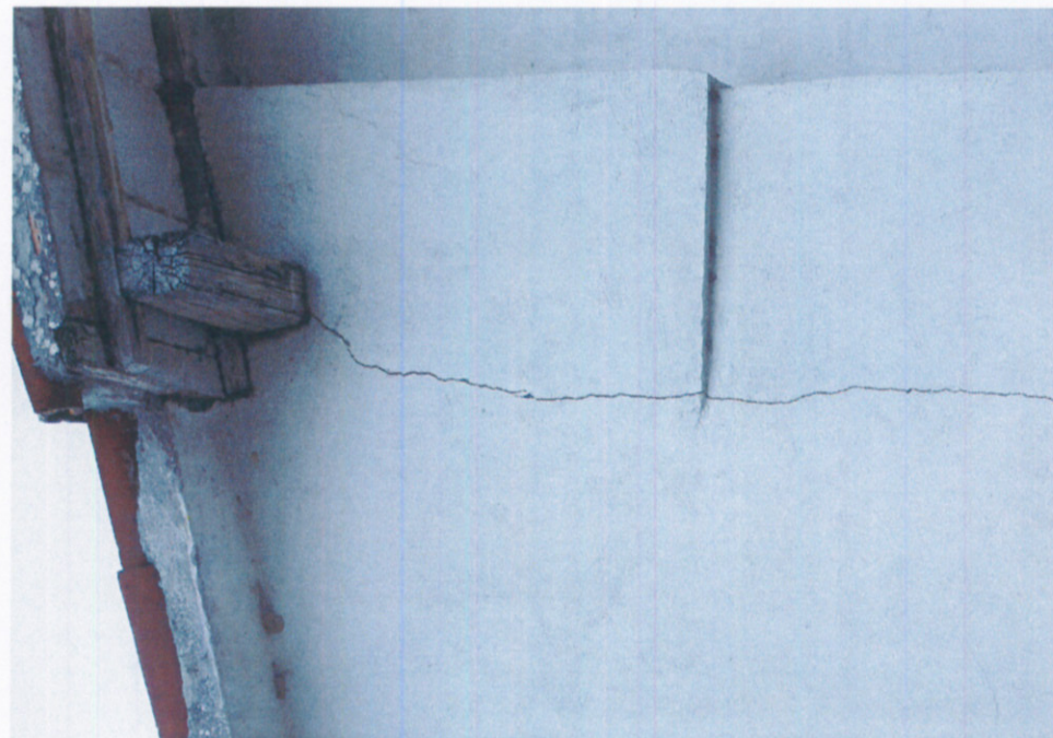
14) Particolare prospetto nord servizio (2)
