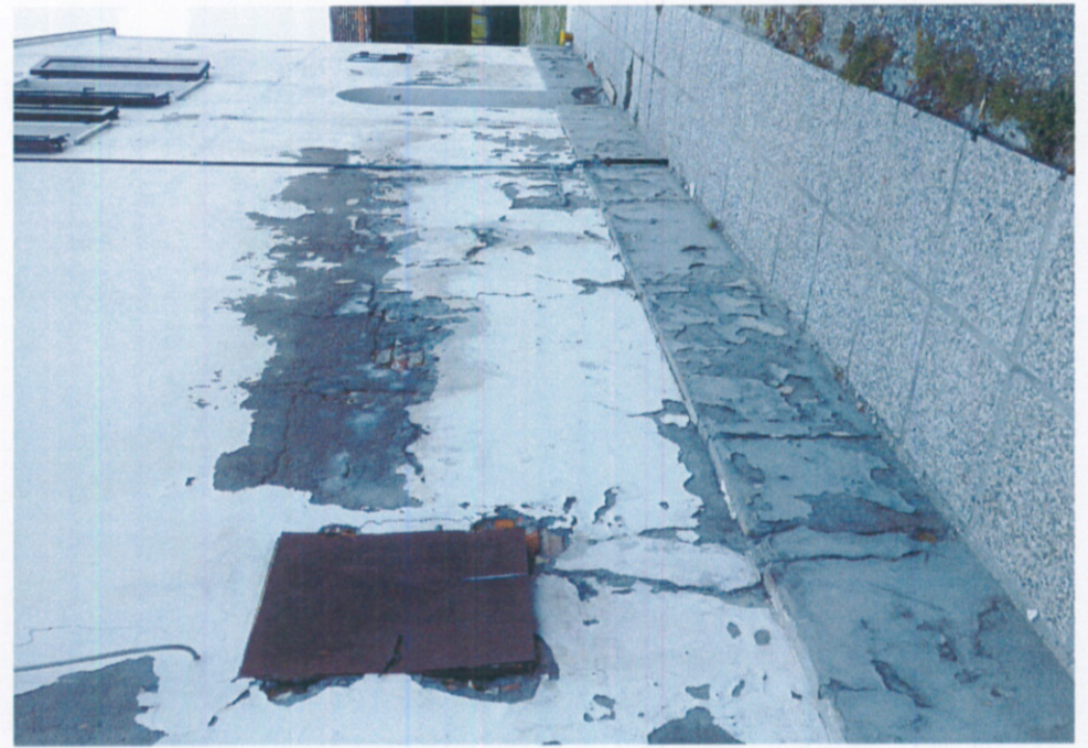
10) Particolare prospetto nord/est Fabbricato Rurale
