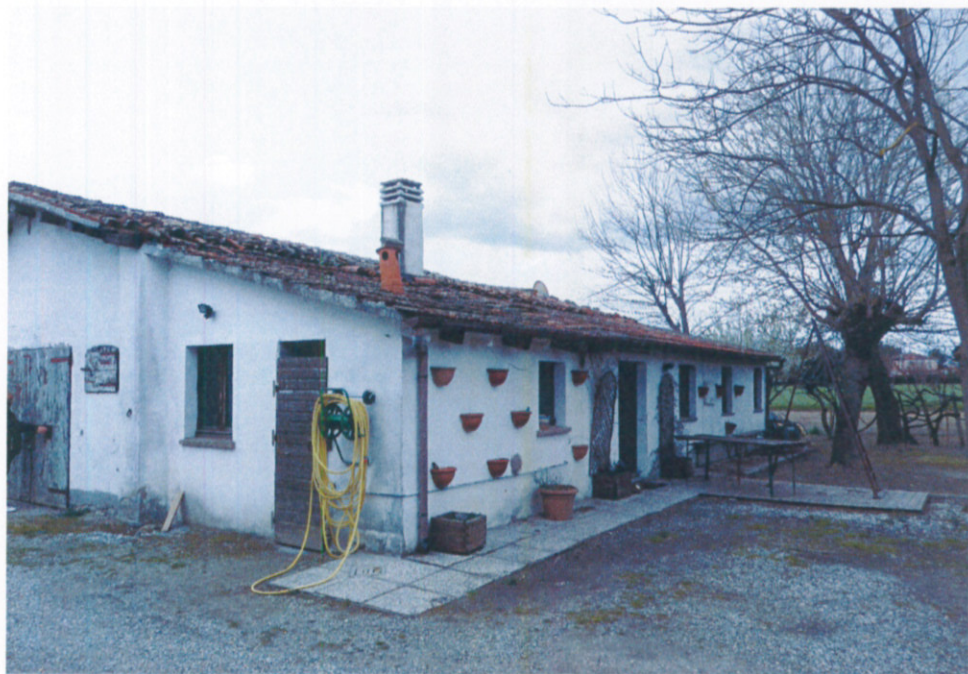
15) Veduta prospetto nord/ovest servizio (2)
