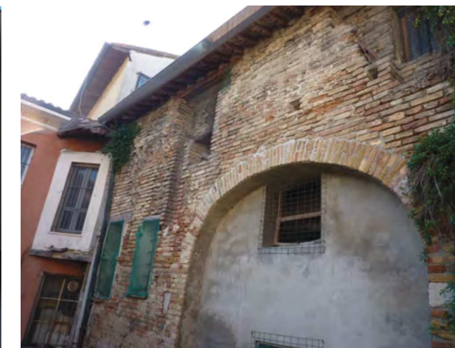
Fronte sul cortile interno
